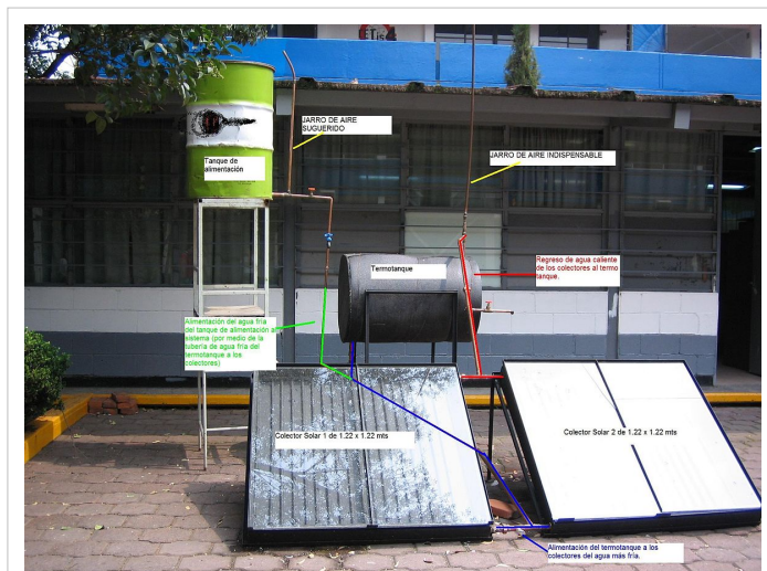
Componentes de un Calentador Solar plano.
